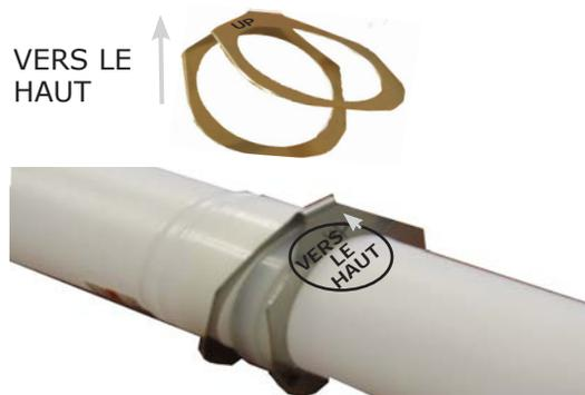
**5.9 Fixation de l'évent en polypropylène du tuyau double****Exemple d'un système d'évacuation Natalini.**
