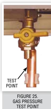
FIGURE 25. GAS PRESSURE TEST POINT
